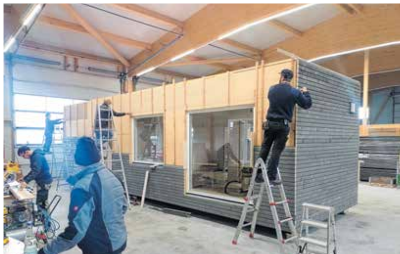
In der Halle wurde das Haus montiert. Dann wurde es nach Rot gefahren, aufgestellt und Strom und Wasser angeschlossen.
